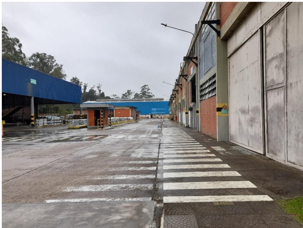
Registro Fotográfico 12: Vista geral da iluminação externa do empreendimento.
