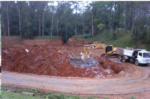
Figura 20 – Vista da ADR 3 (a jusante), com o dique já aberto e com o resíduo totalmente removido e as atividades de remoção de lodo na lateral da ADR-2.
