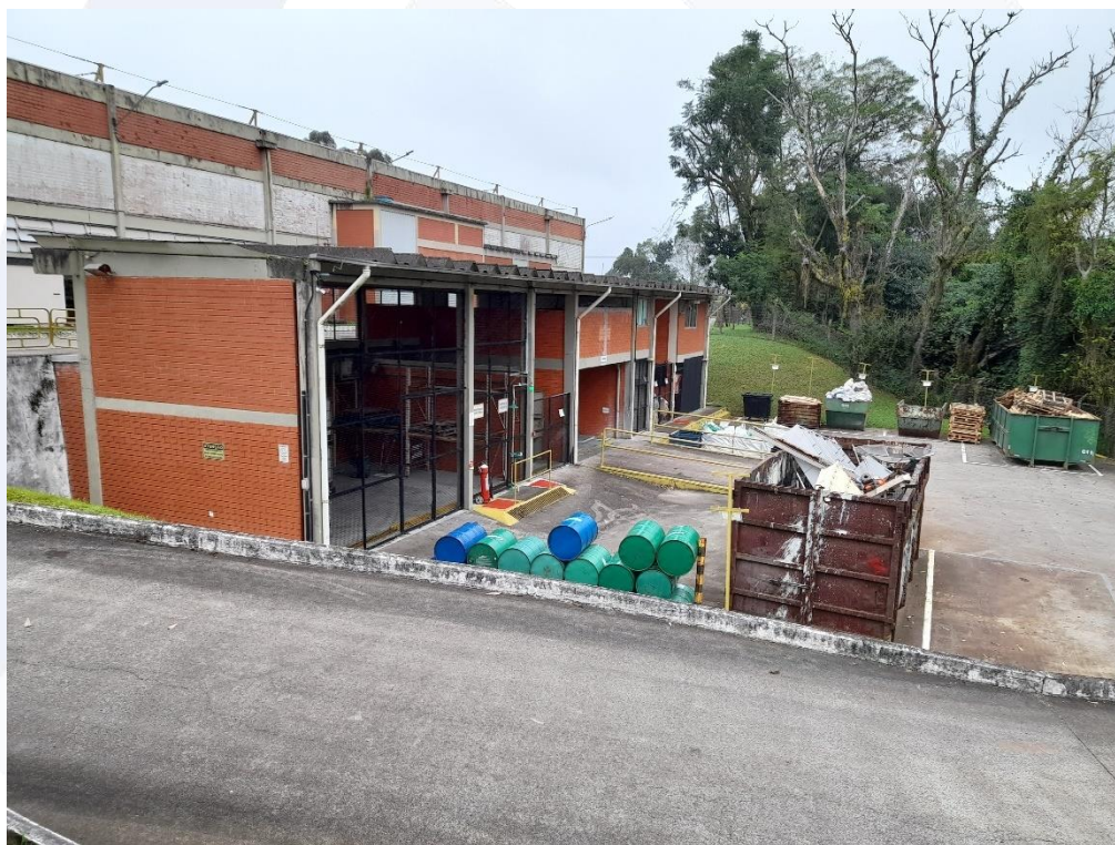
Registro Fotográfico 13: Local de armazenamento de resíduos industriais.
