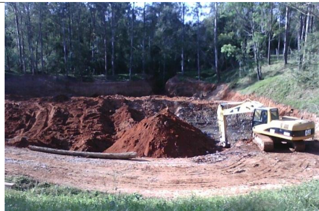
Figura 19 – Vista da remoção e estocagem de argila na própria cava da ADR, após remoção de parte dos resíduos.
