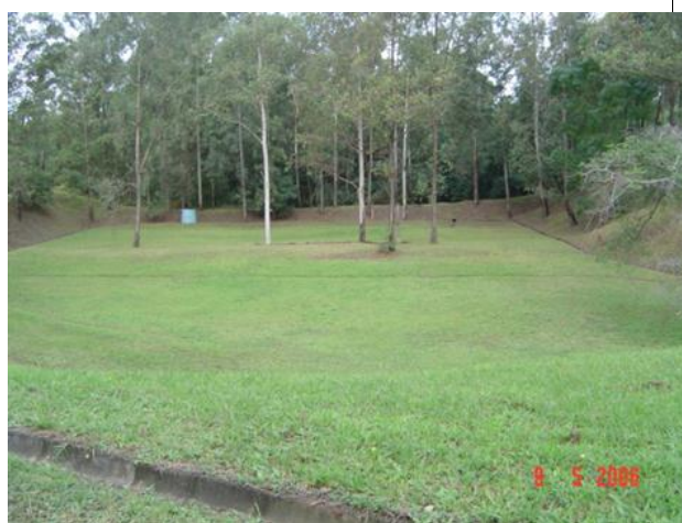
Figura 21 - ADR's 2 e 3, com a cobertura e o resíduo em Maio de 2006
