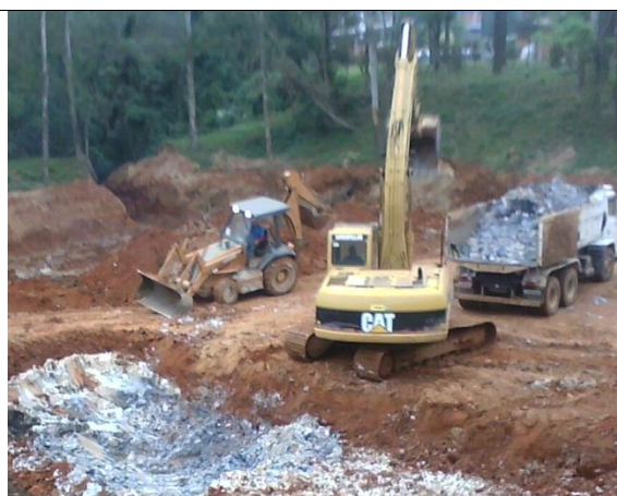
Figura 23 – Remoção do resíduo de forma seletiva, da ADR
