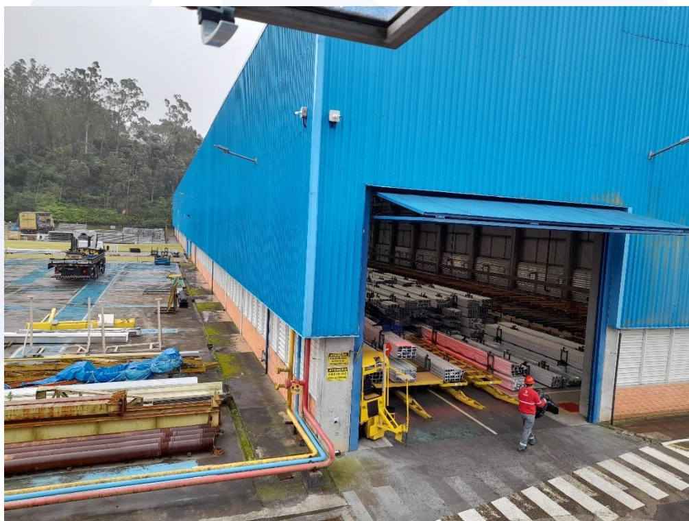
Registro Fotográfico 11: Vista geral externa do pavilhão.
