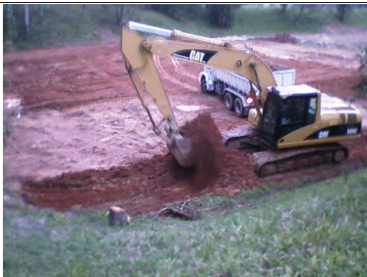
Figura 14 – Início da escavação e remoção da camada de argila de cobertura da ADR
