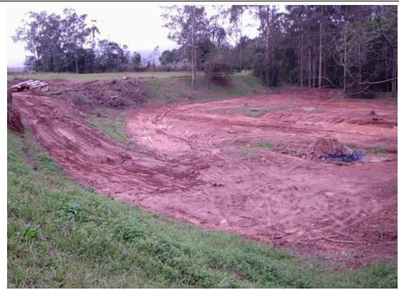
Figura 13 – Remoção da grama e capa de solo orgânico.
