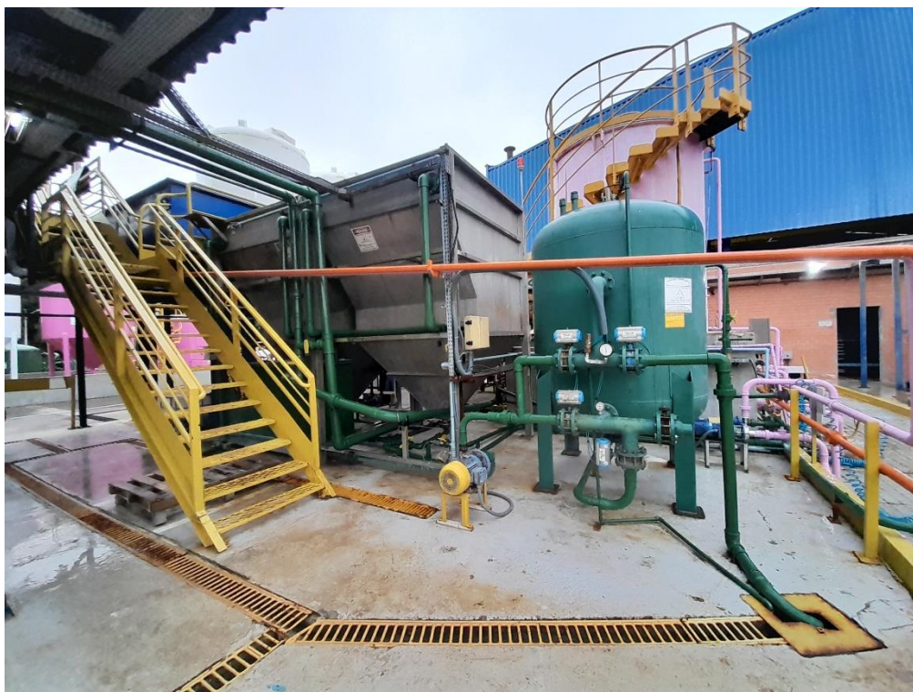
Registro Fotográfico 20: Estação de Tratamento de Efluentes e Sistema de Reúso.
