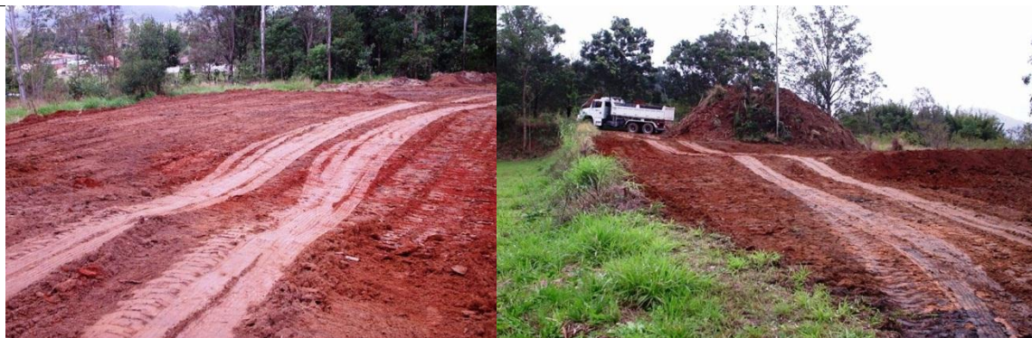
Figura 09 – Área de Estocagem temporária de argila removida da cobertura do aterro
