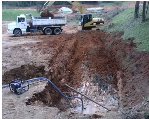
Figura 15 – Escavação da primeira faixa paralela ao dique, com remoção da água aflorante.
