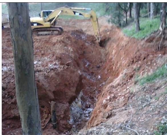
Figura 17 – Escavação de vala na extremidade esquerda da ADR, delimitando sua área nesta direção.
