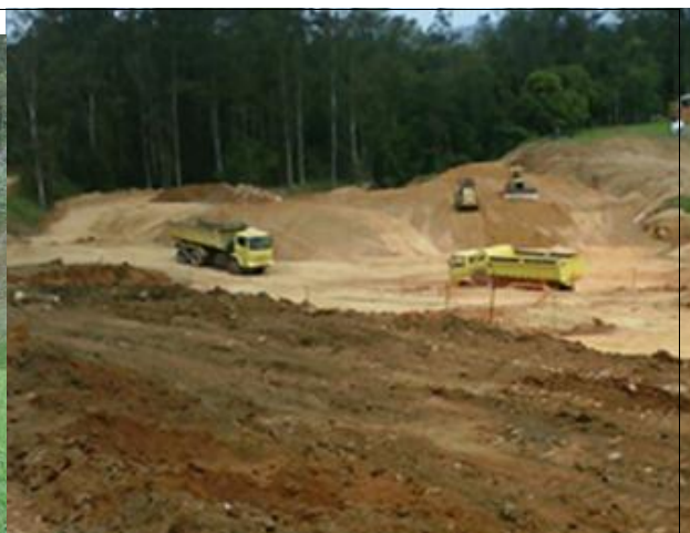
Figura 22 – Vista das ADR's removidas e obras de terraplenagem de integração da área ao uso industrial.
