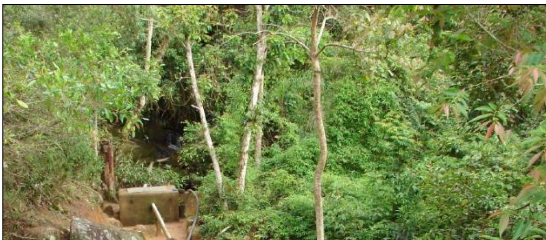
Figura 4 - Vista local da adutora principal (Captação de água do morro)
