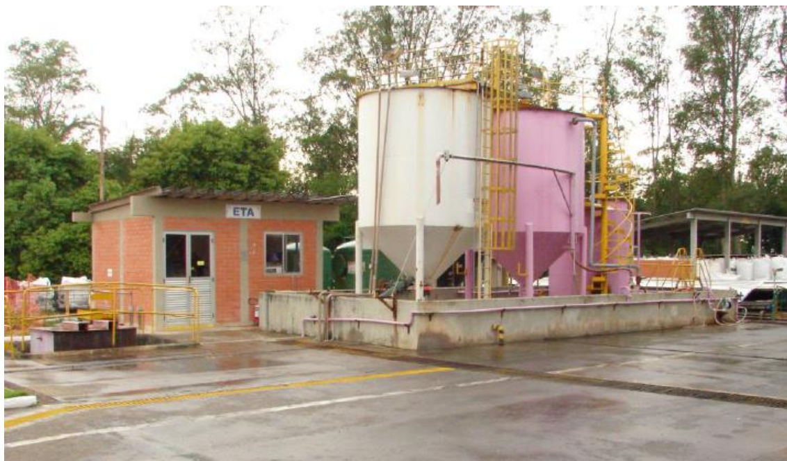
Figura 8 - Detalhes da ETA; disposição dos equipamentos e das tubulações.
