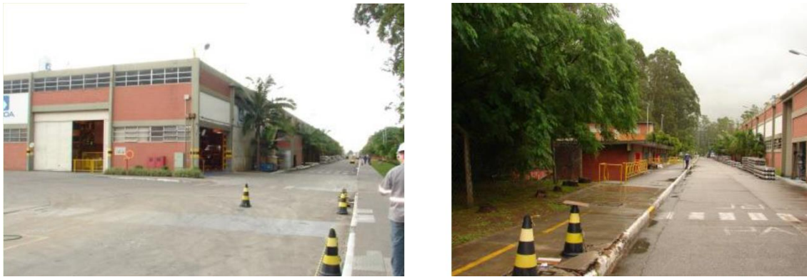
Figura 32 - Lado Oeste da Fábrica
