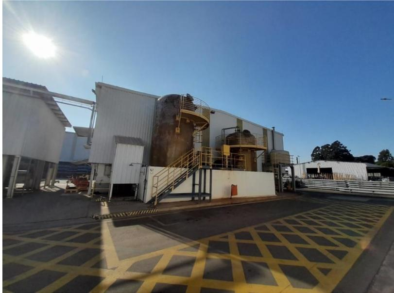
Figura 14: Vista geral do tanque com barreira de contenção para evitar acidentes.
